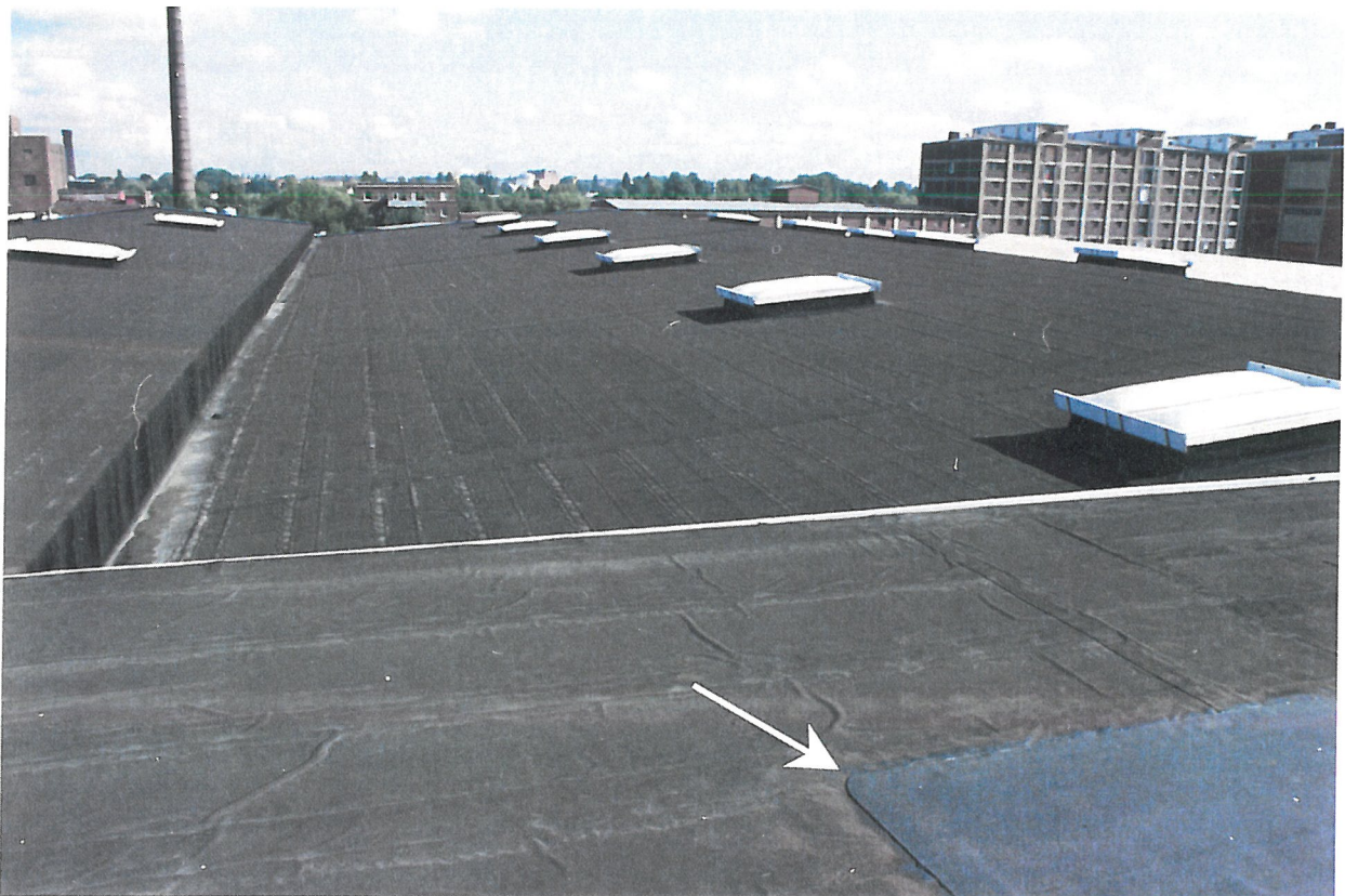
Bild 2: Probenentnahme aus der Dachabdichtung des BV „HH-Veddel, Industriegebäude“
