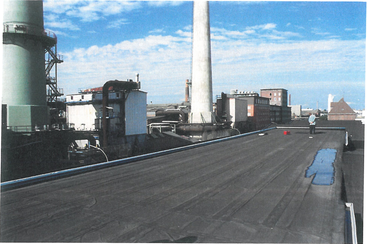
Bild 1: Begutachtung der Dachfläche des BV „HH-Veddel, Industriegebäude“
